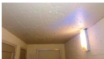
plafond isoleren met PS
